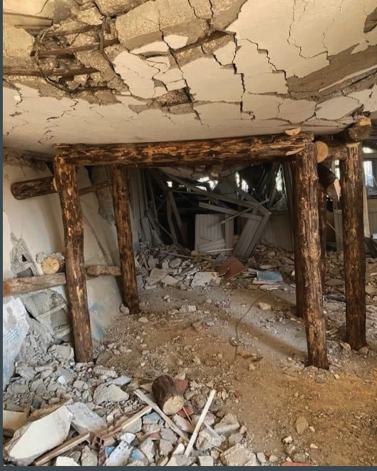
Enkaz çalışmalarında domuz damı tünel kurulumu
