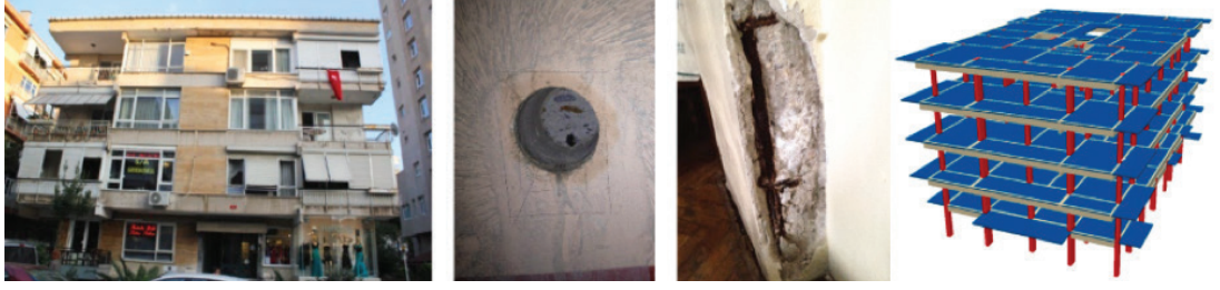
Şekil 1. (a) Mevcut bir betonarme bina örneği (b) Beton karot numunesi alınır (c) İnşaat demiri tipi ve korozyon seviyesi kontrol edilir (d) Yapısal yazılım modeli oluşturulur. 12
